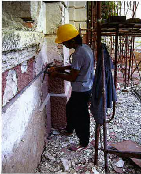
Foto 7: Kerja-kerja penggantian batu bata baru dan memecahkan lepaan yang rosak Sumber: Projek Pemuliharaan HSBC, Melaka, 2009
