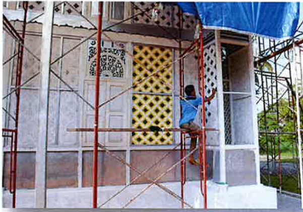
Foto 20: Kerja-kerja mengecat kelarai dinding Sumber: Projek Pemuliharaan Masjid Ihsaniah Iskandariah, 2015
