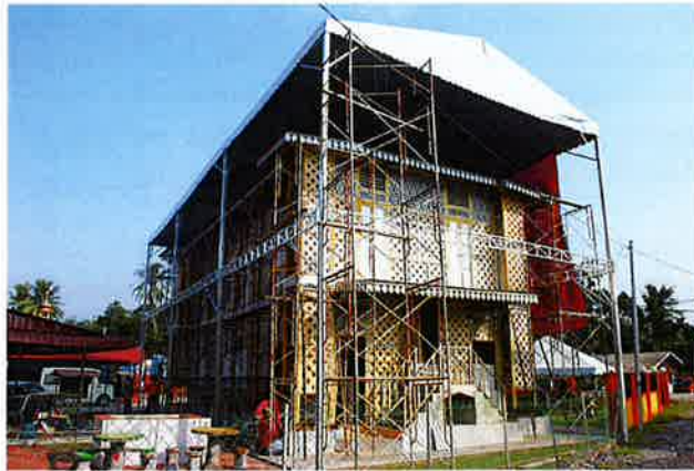
Foto 3: Pembinaan bumbung sementara perlu dibuat terlebih dahulu sebelum kerja pemuliharaan dilakukan Sumber: Projek Pemuliharaan Masjid Ihsaniah Iskandariah, 2015
