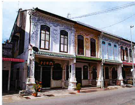
Foto 18: Deretan Rumah kedai di Kampung Cina, Melaka mempunyai elemen ragam hias yang unik pada fasad bangunan.
