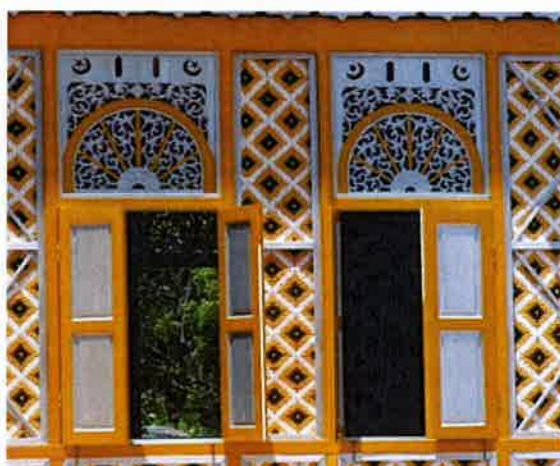
Foto 14: Tingkap Masjid Lama Kampung Kuala Dal, Kuala Kangsar, Perak. Tingkap ini menampilkan keunikan kerawang pada bahagian atas tingkap Sumber: Projek Pemuliharaan Masjid Kampung Kuala Dal, Perak, 2015
