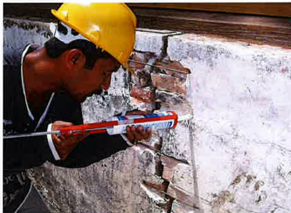
Foto 8: Kerja-kerja "Stapling" pada permukaan dinding untuk mengukuhkan struktur Sumber: Baikpulih Rumah Penghulu Natar, Merlimau, Melaka, 2009
